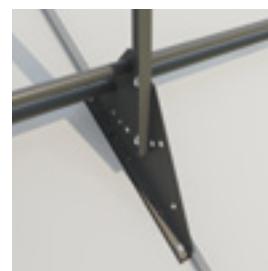
Фальцевая кровля крепление 2
